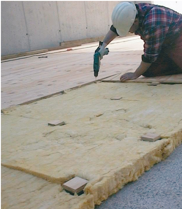
Colocación de tacos cuadrados Sylomer en suelo flotante.
