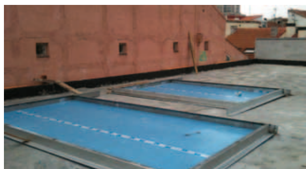
Losa fabricada In situ
