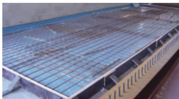
Losa fabricada In situ
