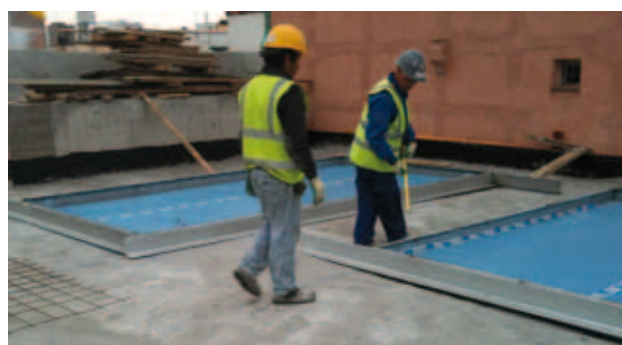
Losa fabricada In situ
