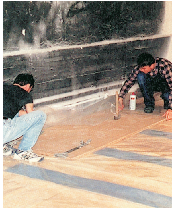
Colocación de Sylomer en tiras bajo tablero DM.
